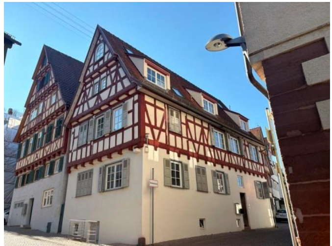
(9) Ansicht von der Nonnengasse mit Hauseingang
