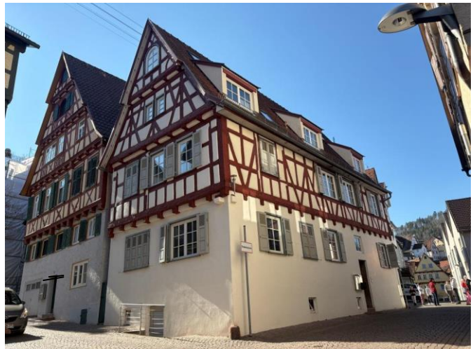
(1) Ansicht von der Ecke Postgasse / Nonnengasse
