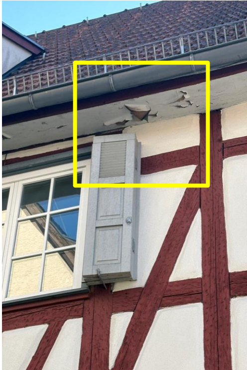
Detail Fassade und Dachrand
