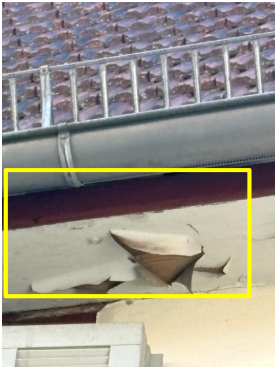
Detail Fassade und Dachrand
