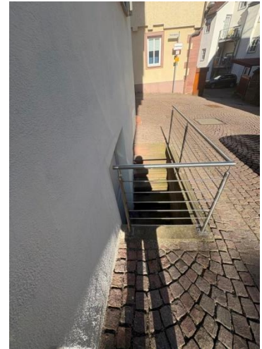
(4) Treppe zum UG an der Postgasse
